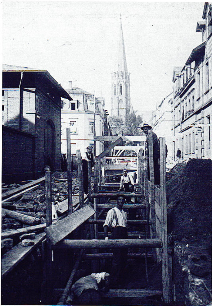
Kanalisationsarbeiten in der Schwesternstraße 1924/26. Bild rechts oben Theodor Neumann
