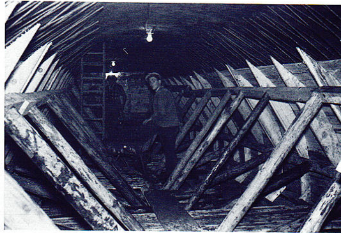
Stahlbeton-Faßbau bei Fa. Haefelin 1960
