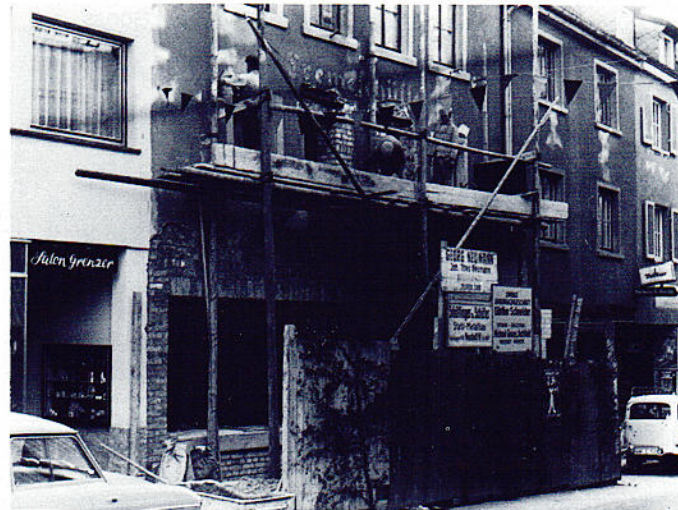
Umbau der alten Cremeschüssel in der Hauptstraße zu einem Uhrenfachgeschäft, Architekt: Michael Gooss
